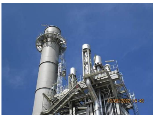
ภาพที่ 2-5 Silencer บริเวณปลายท่อ ที่อาจก่อให้เกิดเสียงดัง
