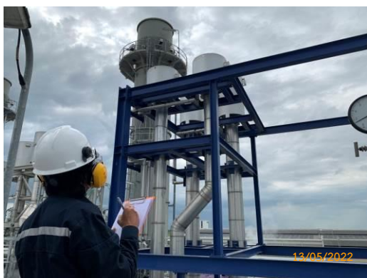
ภาพที่ 2-7 การตรวจสอบ Silencer
