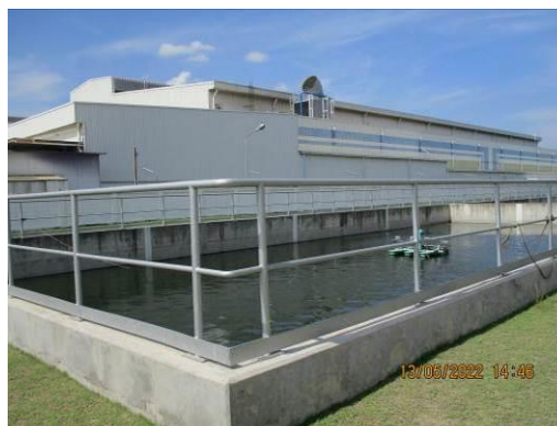
ภาพที่ 2-10 บ่อพักน้ำหล่อเย็น
