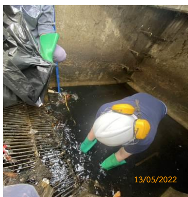
ภาพที่ 2-31 การตรวจสอบรางระบายน้ำฝน ในพื้นที่โครงการฯ
