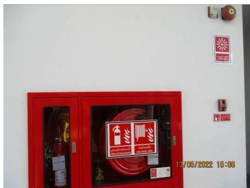
ภาพที่ 2-37 ระบบป้องกันเพลิงไหม้และระบบดับเพลิงของโครงการฯ (ต่อ)
