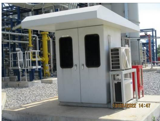
ภาพที่ 2-2 ระบบ CEMs ของปล่อง HRSG 11 และปล่อง HRSG 12
