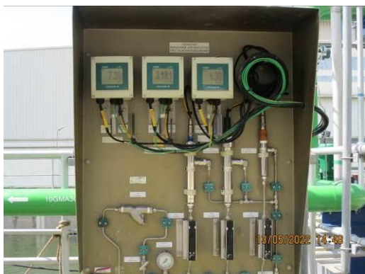
ภาพที่ 2-11 ระบบ Online Monitoring บริเวณบ่อพักน้ำหล่อเย็น
