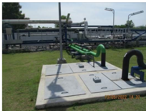
ภาพที่ 2-12 วาล์วควบคุมการปล่อยน้ำทิ้งจากหอหล่อเย็น
