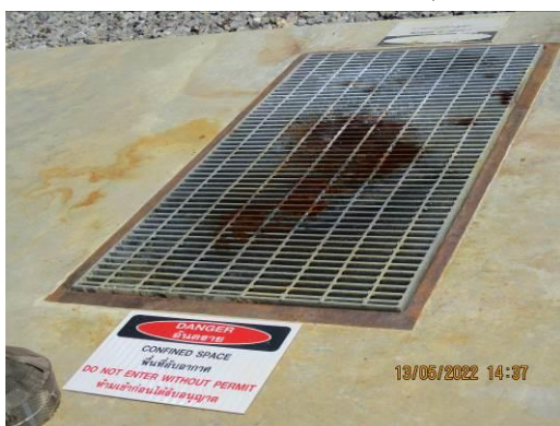
ภาพที่ 2-17 บ่อปรับสภาพความเป็นกรด-ด่าง (Neutralization)
