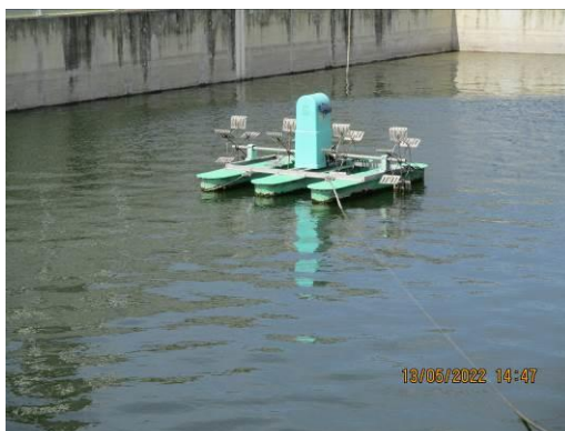
ภาพที่ 2-54 เครื่องเติมอากาศในบ่อ CT Blowdown
