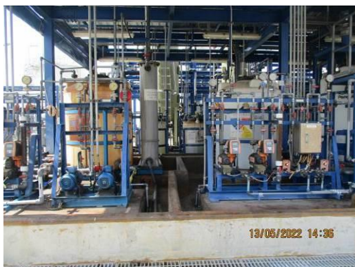
ภาพที่ 2-44 คั่นกันสารเคมีหกรั่วไหล
