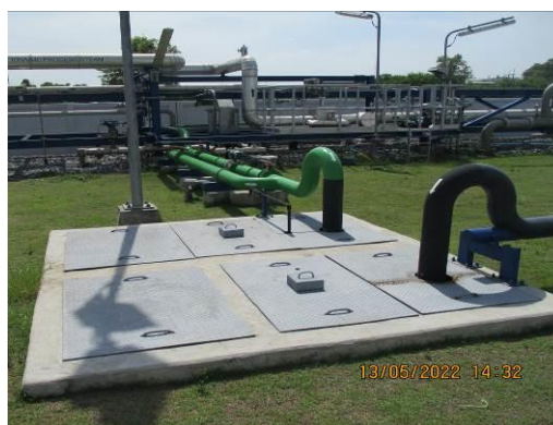
ภาพที่ 2-18 ท่อระบายน้ำทิ้งจากบ่อพักน้ำทิ้งรวม ไปยังระบบบำบัดน้ำเสียส่วนกลางของนิคมฯ
