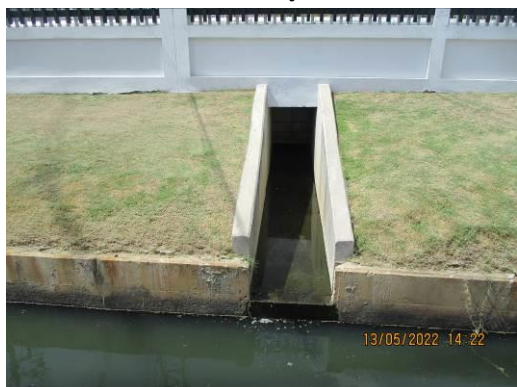
ภาพที่ 2-29 รางระบายน้ำฝนที่เชื่อมต่อกับ ระบบระบายน้ำฝนของนิคมฯ
