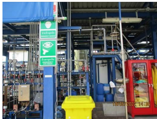
ภาพที่ 2-43 ฝักบัวอาบน้ำฉุกเฉิน และที่ล้างตาฉุกเฉิน
