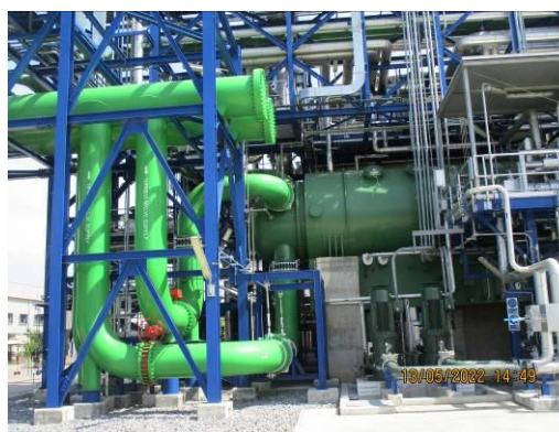
ภาพที่ 2-14 เครื่องควบแน่น (Condenser)
